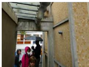
passage entre 2 zones actives trop étroit
