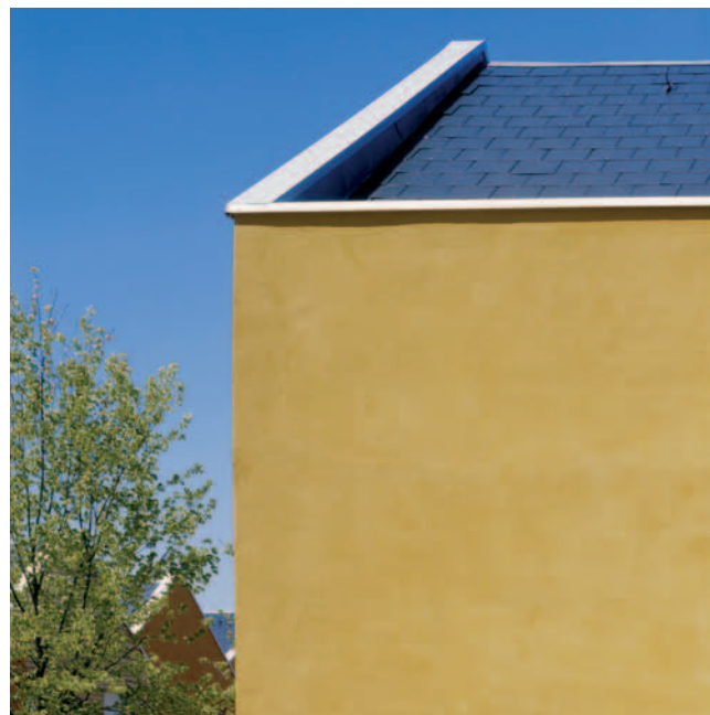
Détail du décaissé de toiture pour marquer les frontons et intégrer les chéneaux © Benoît Fougeirol
