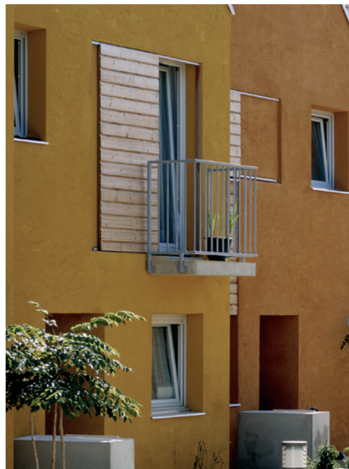
Détail des volets coulissants intégrés en feuillure © Benoît Fougeirol
