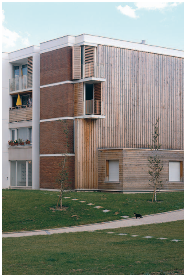
Vue des balcons créés © Benoît Fougeirol
